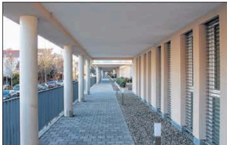
Die 120 Meter Passerelle auf der hoch gelegenen Erdgeschoss-Ebene, die alle vier Häuser barrierefrei miteinander verbindet.
